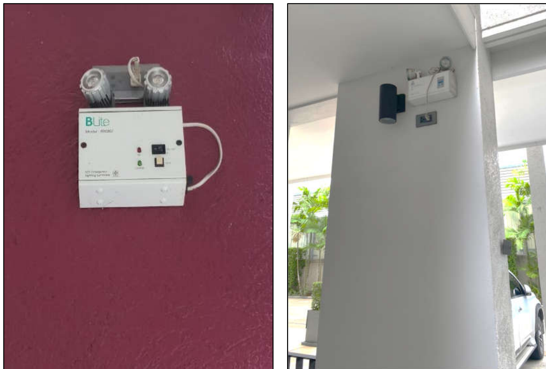
ภาพที่ 25 แสดงไฟส่องสว่างฉุกเฉิน
