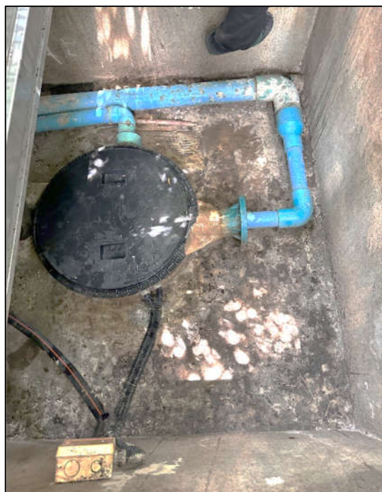
ภาพที่ 44 แสดงถังเก็บน้ำสำรองใต้ดิน
