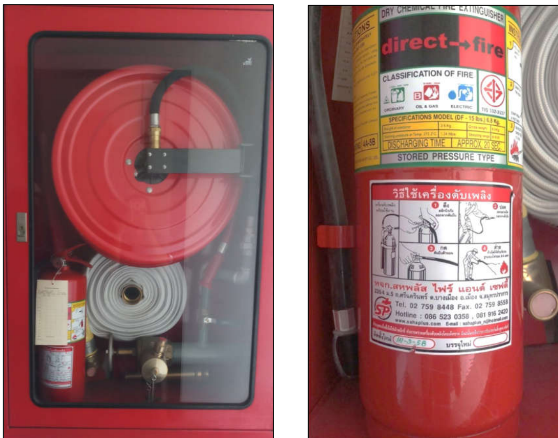
ภาพที่ 27 แสดงตู้อุปกรณ์ดับเพลิง & วิธีการใช้งาน
